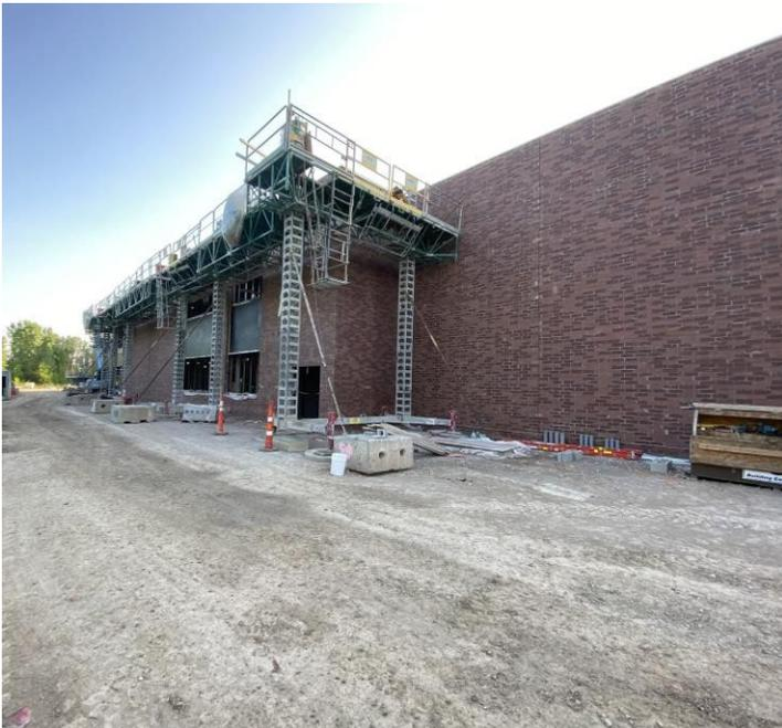
El ladrillo exterior está a punto de ser terminado en el lado oeste del edificio.
