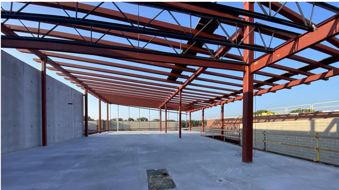
La estructura de acero de la biblioteca ya está colocada y se ha vertido el concreto del piso.
